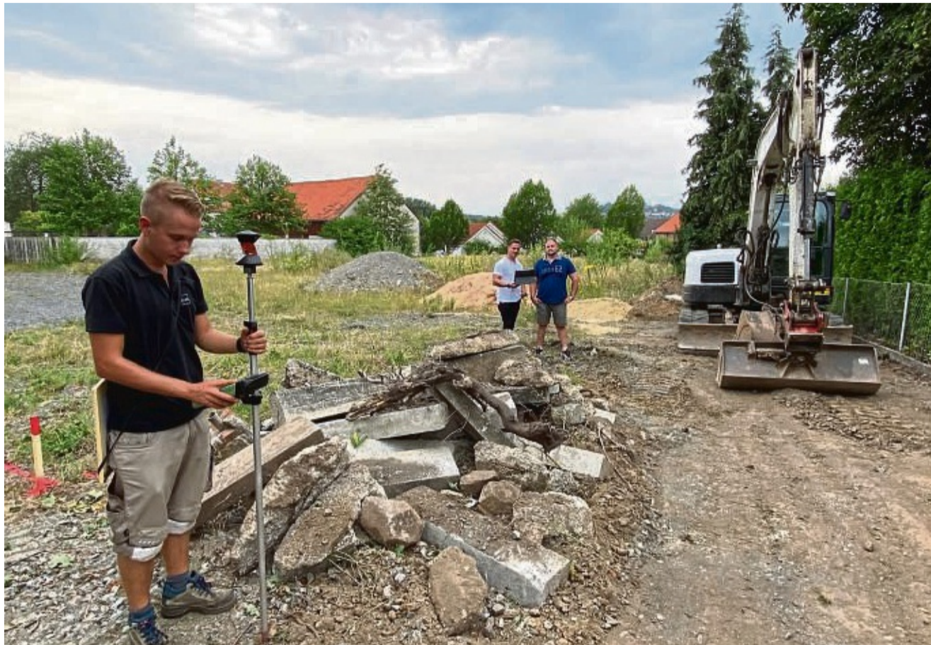
Baubeginn in Ehlen: Investor Wilhelm Kling und Planer Mirco Schmidt (links hinten) trafen sich auf dem ehemaligen Rewe-Gelände, auf dem der Wohnpark entsteht. Moritz Schneider erledigt letzte Vermessungsarbeiten. FOTO: BEA RICKEN
